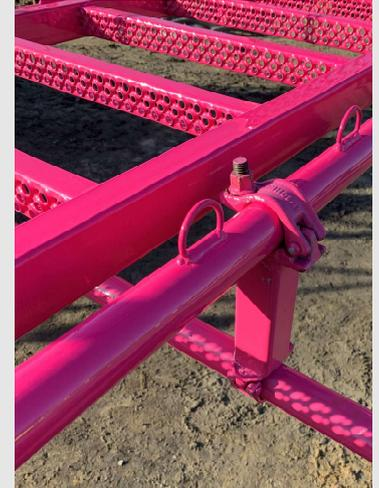
01 Am unteren Podest und an einem geeigneten Zwischenstück befinden sich Stützrohre mit Klemmhalterung die vor dem Einsetzen der Leiter auf den benötigten Abstand zwischen Spundwand und Leiter eingestellt werden. Der Mindestabstand muss 150 mm betragen.
