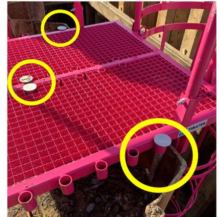
03 Sobald der obere Podest aufliegt müssen die Haltebolzen in die entsprechenden Bohrungen gesteckt, und mit Splinten gesichert werden.
