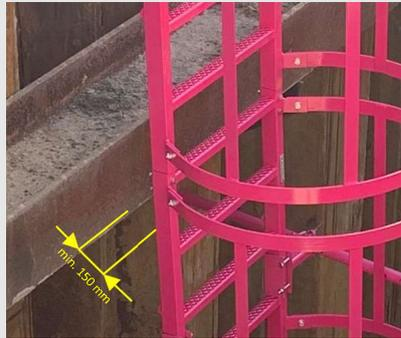
03 Als nächstes wird die Halterung für die Anlegeleiter auf die gewünschte Höhe am unteren Podest montiert. Auch dies geschieht mittels Klemmschellen.
