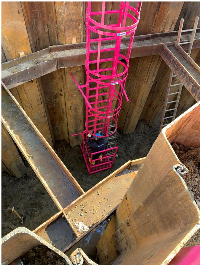
Die Spundwandleiter ist nun verwendungsfertig aufgebaut
