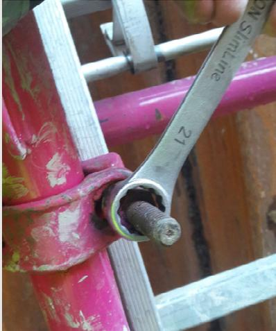
02 Nach dem Festklemmen der Halteschellen werden die Sicherungsbolzen durch die Stützrohre gesteckt und mit Federsteckern gesichert. Sie dienen als zusätzliche Sicherheit, falls sich die Klemmverbindung lösen sollte
