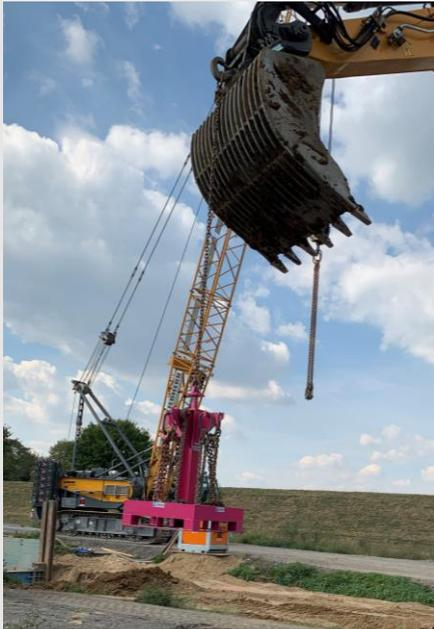
01 Zum Versetzen des Kettenständers kann dieser an einen Bagger oder Kran angeschlagen werden. Ebenso ist ein Transport mittels Radlader + Palettengabel oder Gabelstapler möglich.
